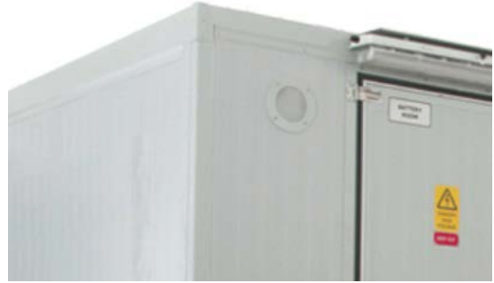
Kompakt Trafo Merkezi Çatısı
